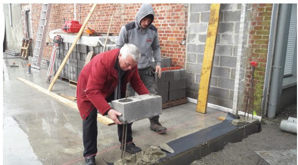
La modification de la salle des fêtes se poursuit. Les murs montent. M. le Maire en a profité pour poser le premier parpaing.
